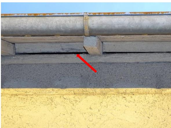
Abb. 5: Spalt am Dachtrauf der Werkshalle
