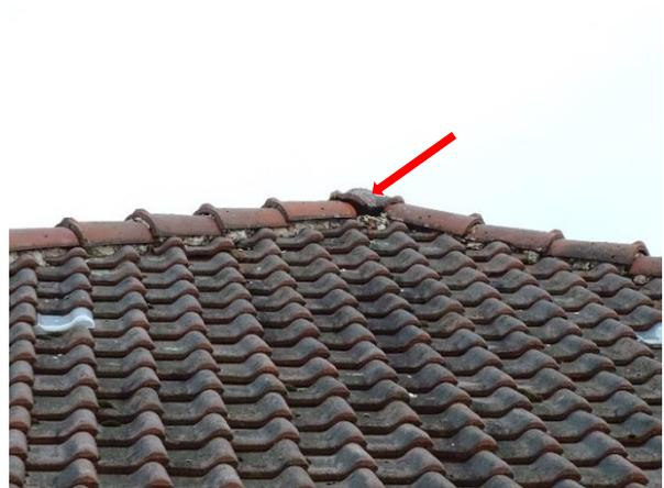
Abb. 4 Abstehender Firstziegel am Dach der Werkshalle
