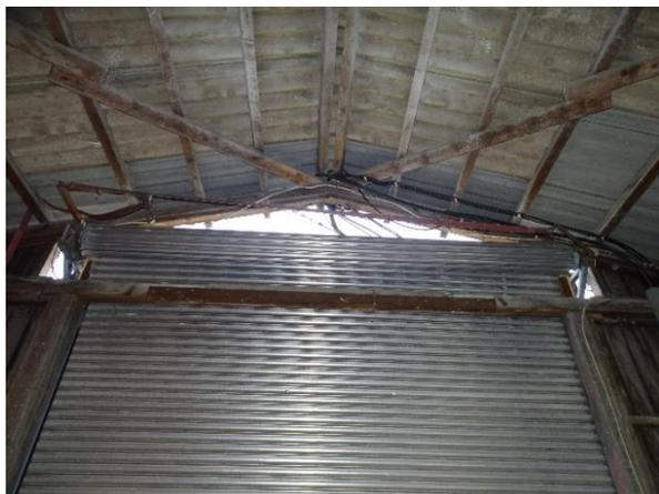
Abb. 13: Einflugmöglichkeit zwischen Lagerhallentor und Dachkonstruktion
